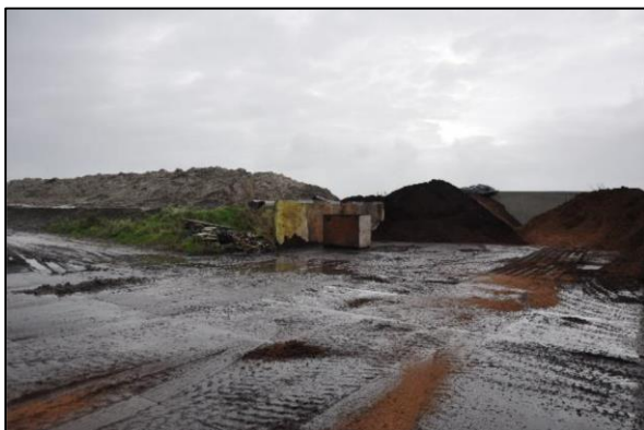
Afb 6: Opslag van grond
