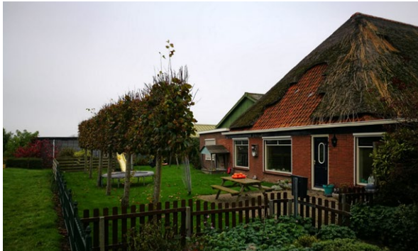
Bestaande stolpboerderij, voorzijde
