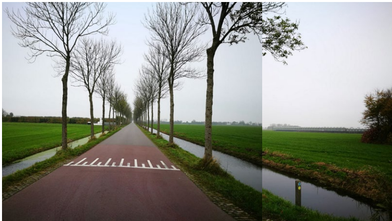
Oosterboekelweg, zicht naar westen, rechts de kassen
