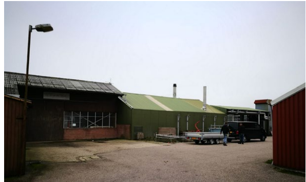
Bestaande opstallen op het terrein, zicht bij toegang erf
