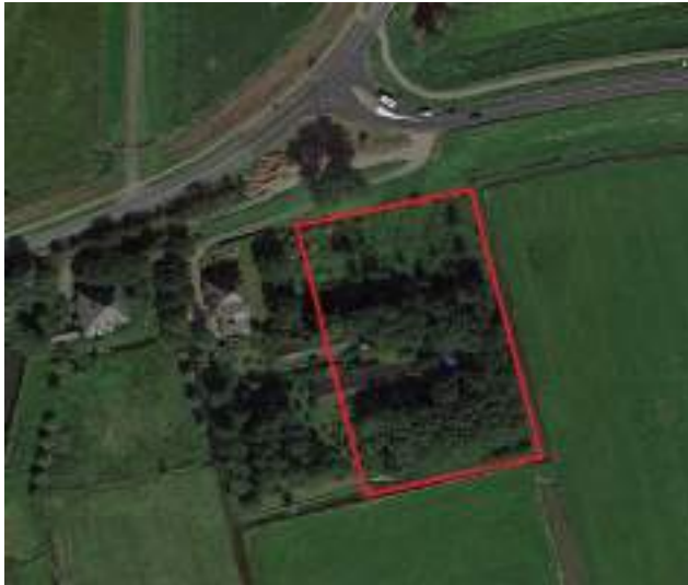
Figuur 1 - Bestaande situatie (Google Maps, 2022)
