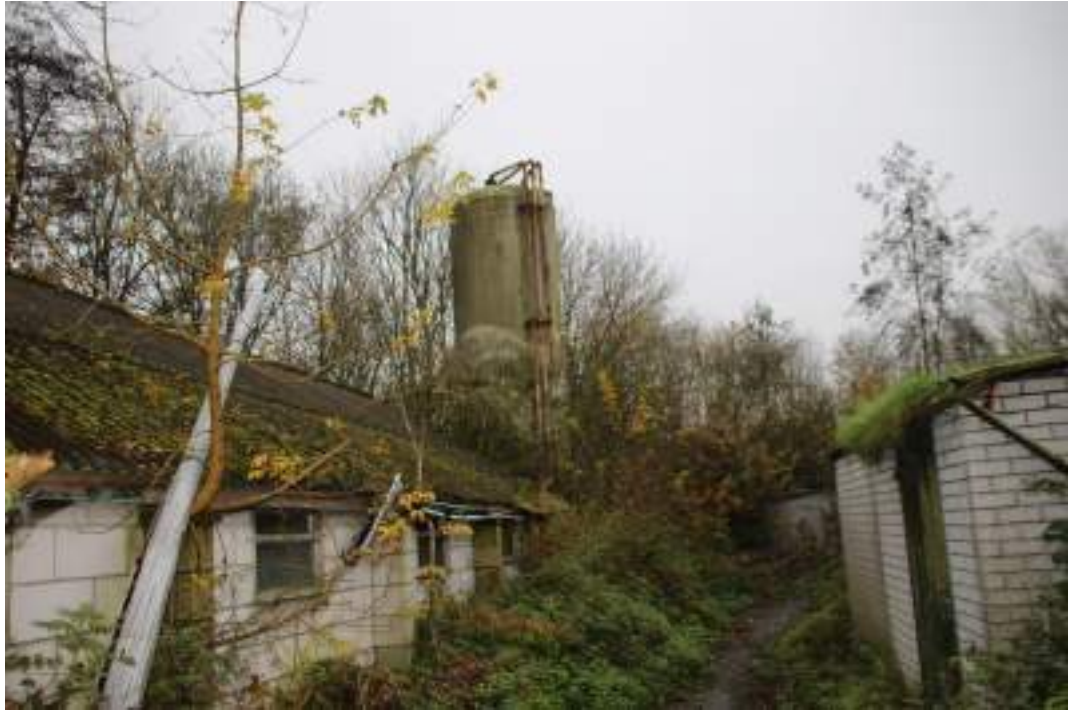
Voormalige varkensstallen en graansilo (nrs. 2 en 5)
