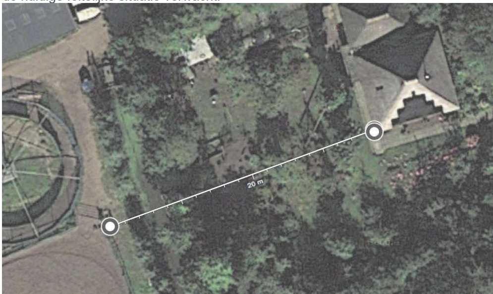
afb.30 Luchtfoto met huidige afstand tussen rijbak en de dichtstbijzijnde burgerwoning Koningspade 29
