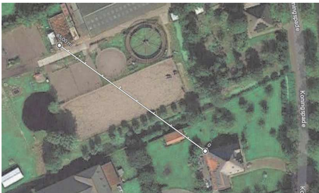
afb.29 Luchtfoto met afstanden tussen emissiepunt stallen en burgerwoning Koningspade 28
