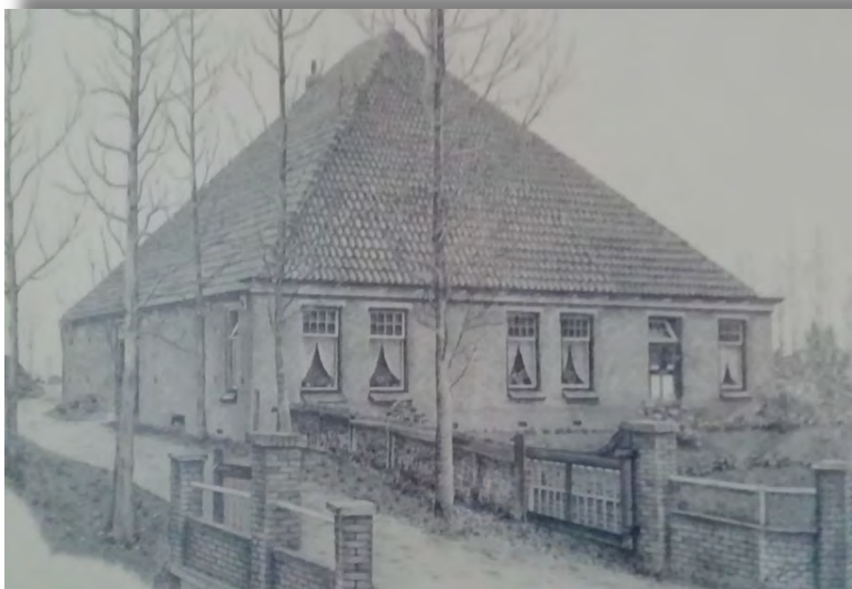
Historisch foto originele stolp Zomerdijk 22, Spanbroek
