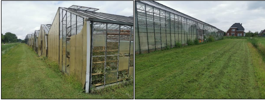
Figuur 2.3: Impressie van het buitenaanzicht van de kas en het gazon. Het gazon wordt regelmatig onderhouden.
