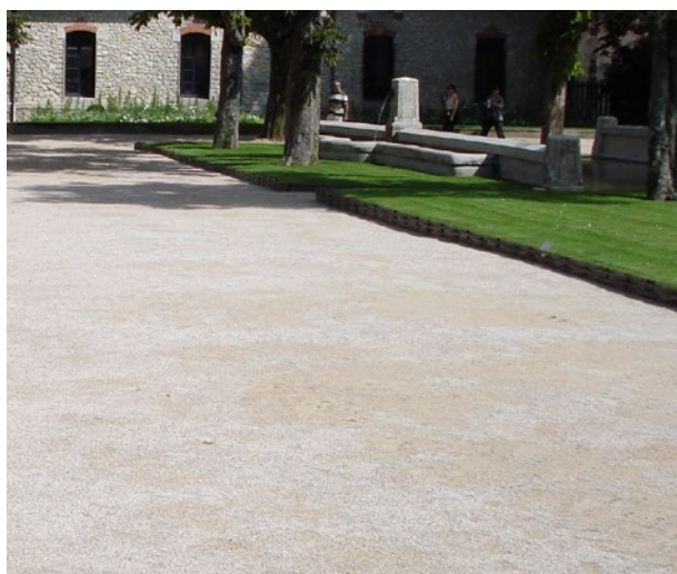
Referentie, oprit van halfverharding
