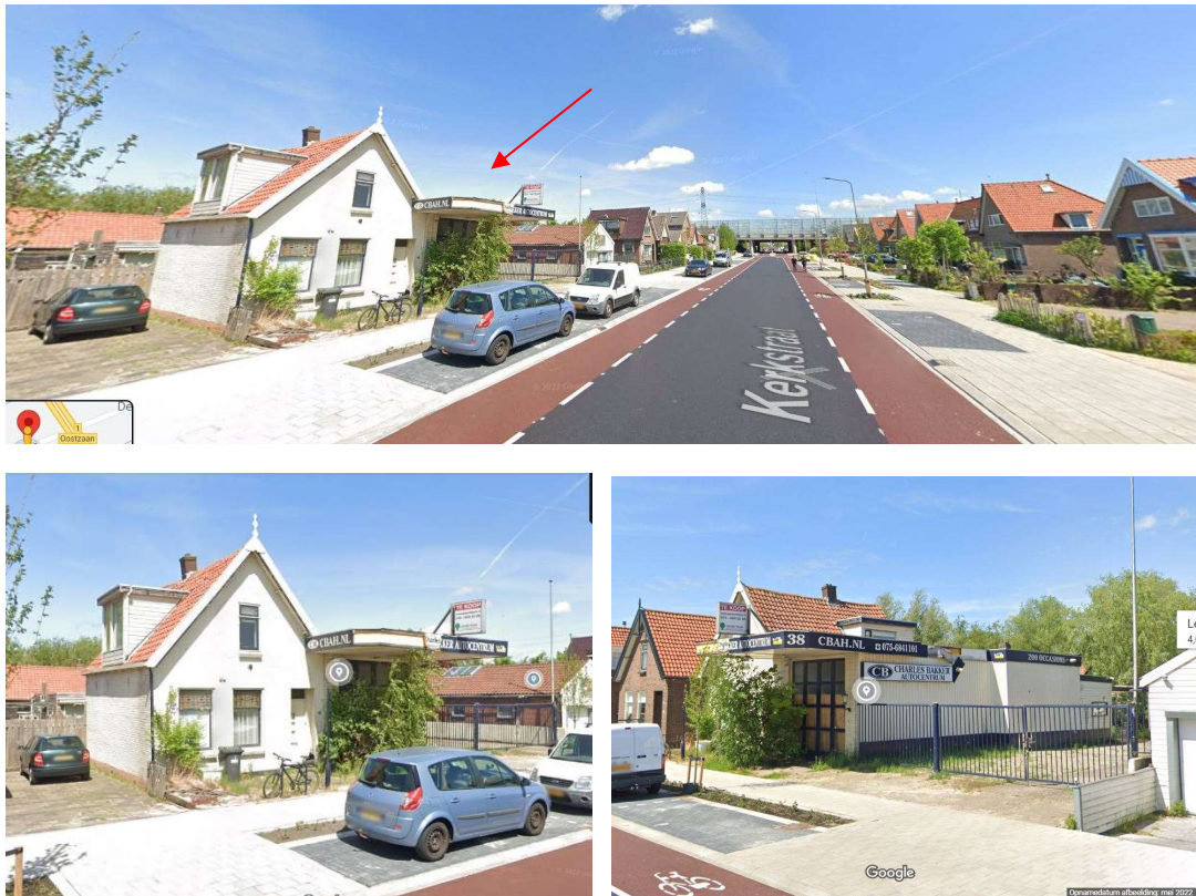
Figuur 1: Woning aan de Kerkstraat 38 te Oostzaan
