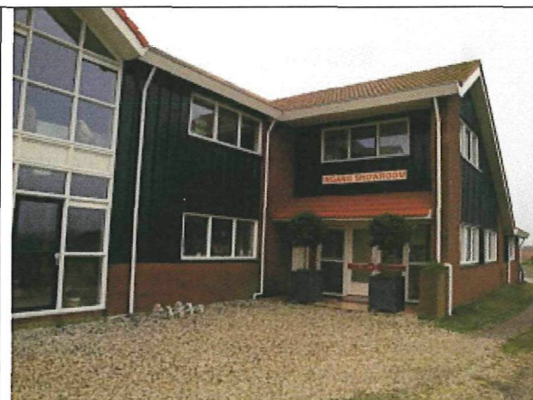
Entree huidig bedrijf - in oostelijke richting gezien
