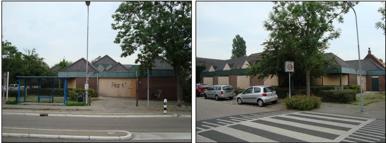
Afbeelding: het inmiddels gesloopte gebouw van de bibliotheek, gezien vanaf het Zuideinde (links) en vanaf de Lisweg (rechts)
