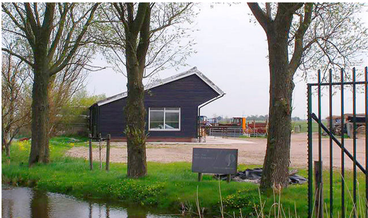
Erf met werkschuur van Staatsbosbeheer, gezien vanaf de openbare weg op de ringdijk van de Wijde Wormer.
