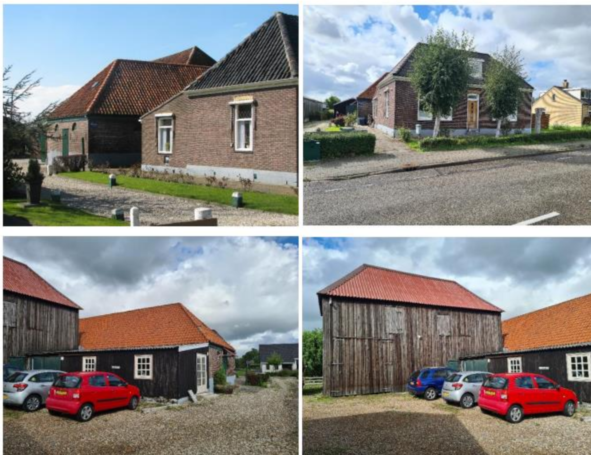
Afbeelding 3: foto's bestaande situatie
