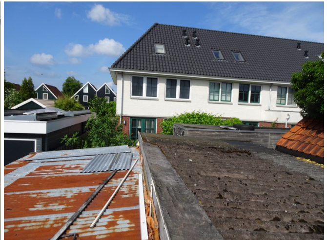
daken van asbest en ijzer golfplaat aanbouwen
