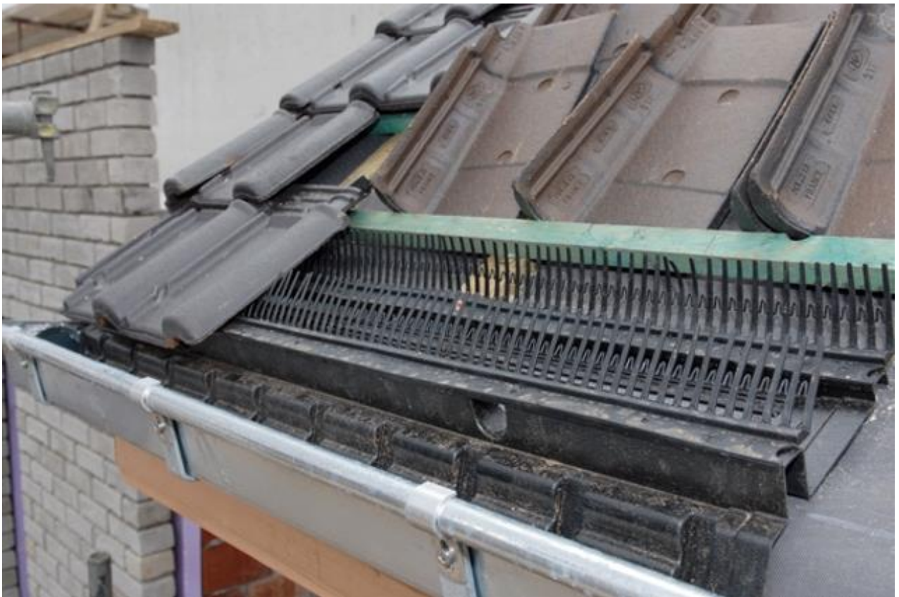
Afbeelding van de montage en plaats van een mussenvide.
