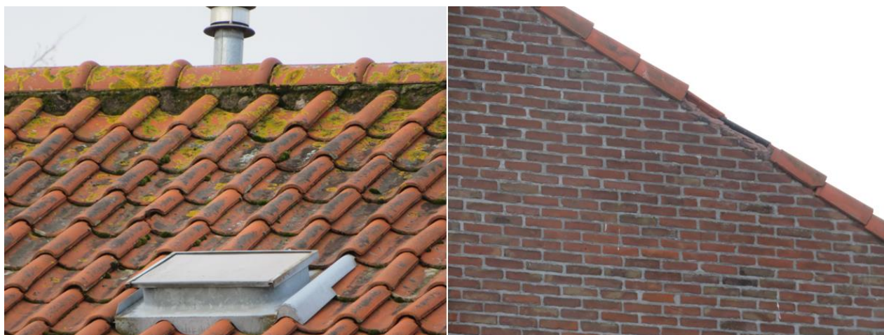
Nauw sluitende pannen en vastgemetselde nok- en geveldakpannen.
