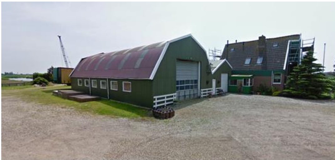
Afbeelding 1: De bestande bebouwing op het perceel De Haal 98.
