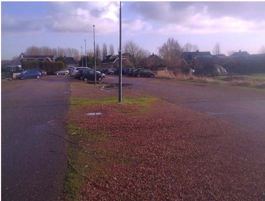
Foto 1. Parkeerplaats Noordeinde 41 te Oostzaan
