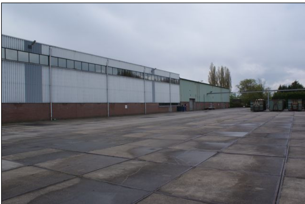
Achterzijde bedrijfsgebouw Meyn.
