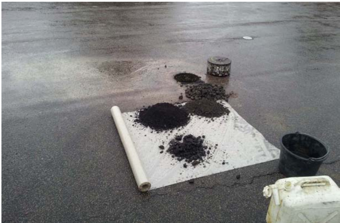
Proefgat 3: Boorgat en monstremateriaal.
