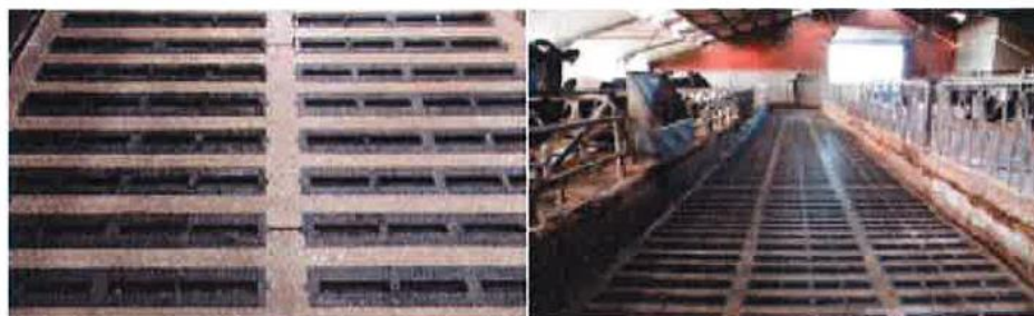
Foto's roostervloer voorzien van afdichtingscassettes in de roosterspleten
