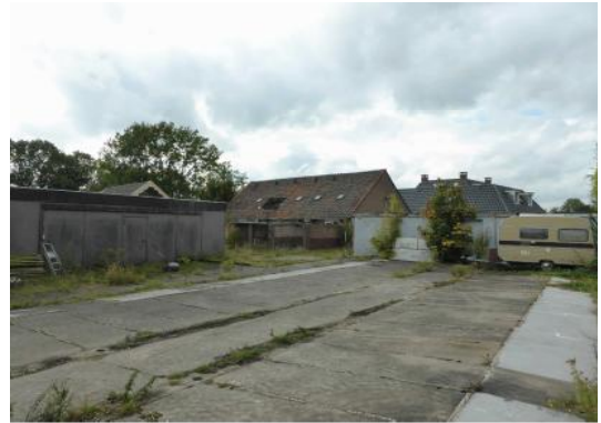
Te amoveren betonplaten
