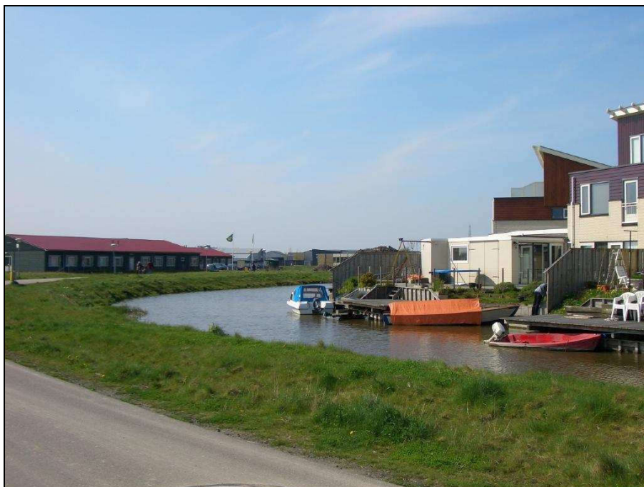
Foto 1. Bestaande bebouwing in Schepenwijk
