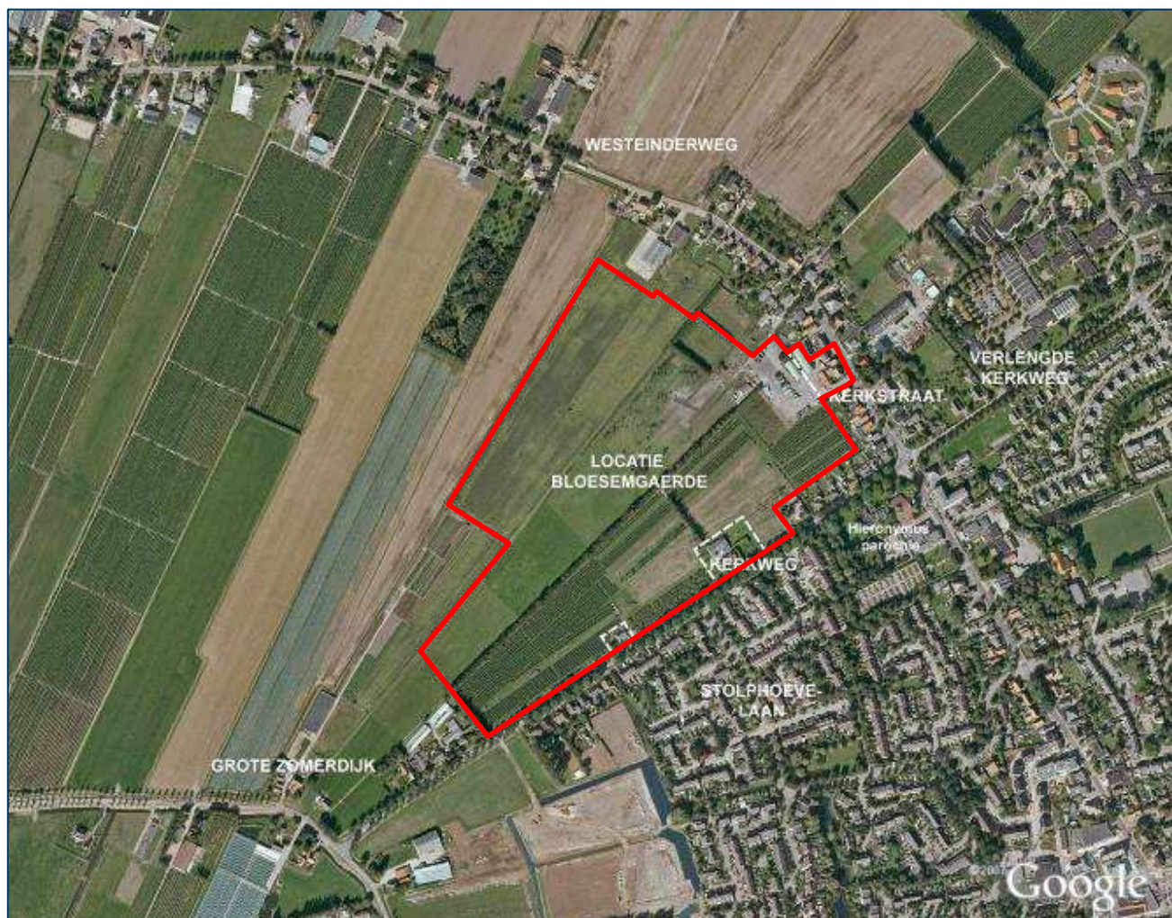
Afbeelding 3 bestaande situatie plangebied
