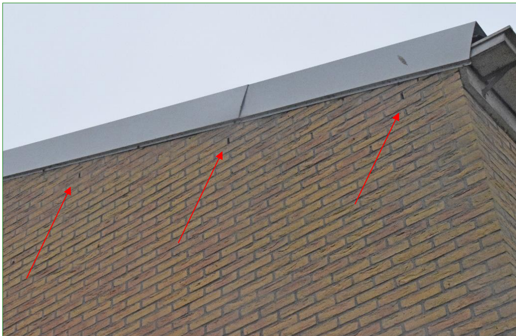
Open stootvoegen in de voorgevel van het bestaande bedrijfsgebouw kunnen toegang geven tot voor vleermuis geschikte ruimten.
