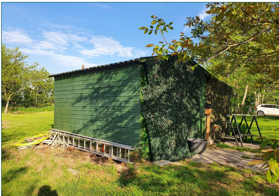
Figuur 3 De schuur wordt gesloopt in de beoogde ruimtelijke ontwikkeling.
