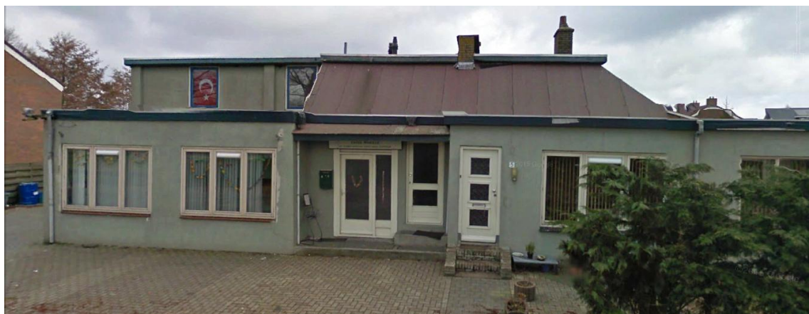
afb. 8 Het bestaand gebouw, dat door 4 woningen zal worden vervangen.
