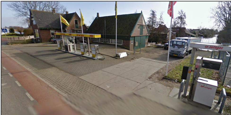
Afbeelding: indruk van de vroegere situatie van het plangebied, de pompinstallaties zijn inmiddels gedemonteerd
