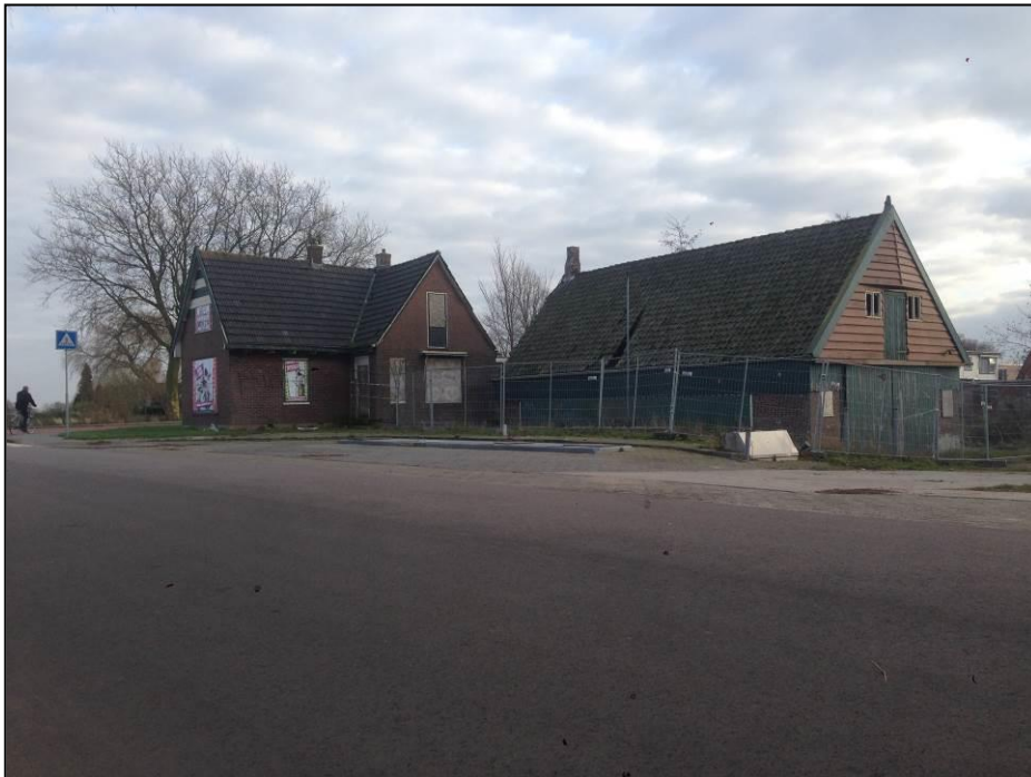
Afbeelding: aanzicht op de bestaande bebouwing van het perceel aan de Kleingouw 1, te Andijk
