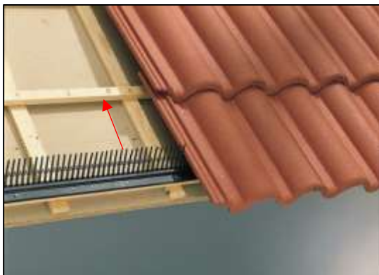
Afb 19: Vogelschroot op tweede panlat
