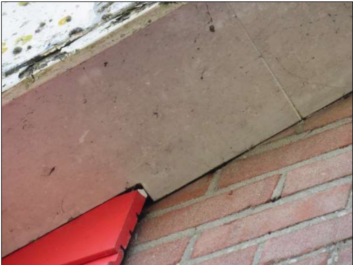
Afb 13: Dakoverstek sluit strak aan op het gevelmetselwerk
