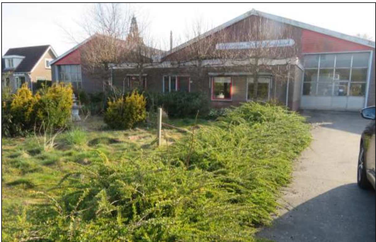
Afb 4: Deel van de voorzijde en een stuk aangelegde tuin
