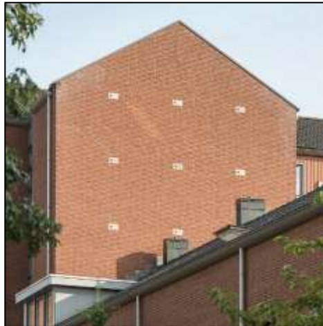
Afb 21 + 22: Gierzwaluwkasten ingemetseld (worden ook gebruikt door Huismussen)
