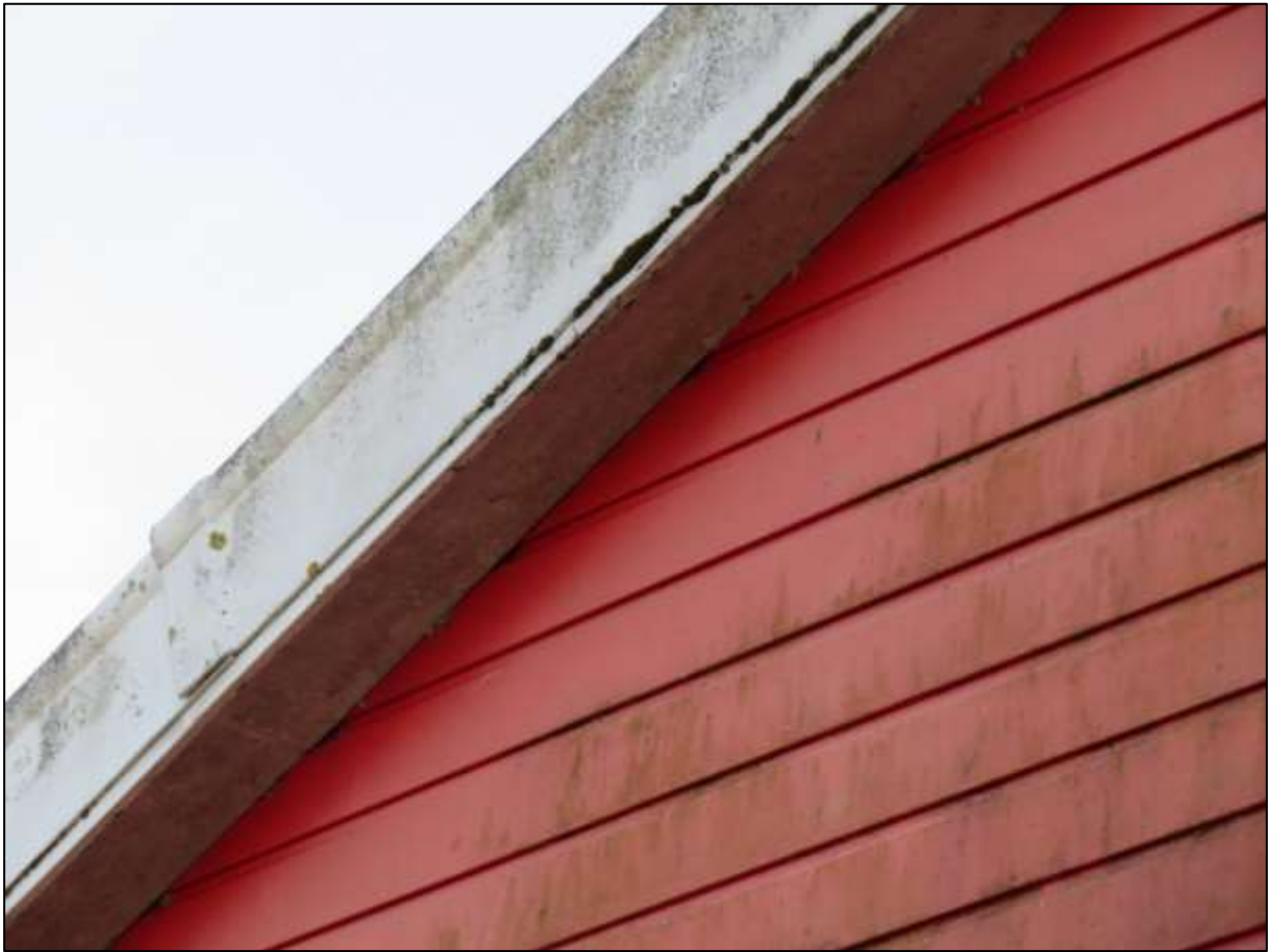
Afb 15: Aansluiting op gevelbekleding is ook dicht
