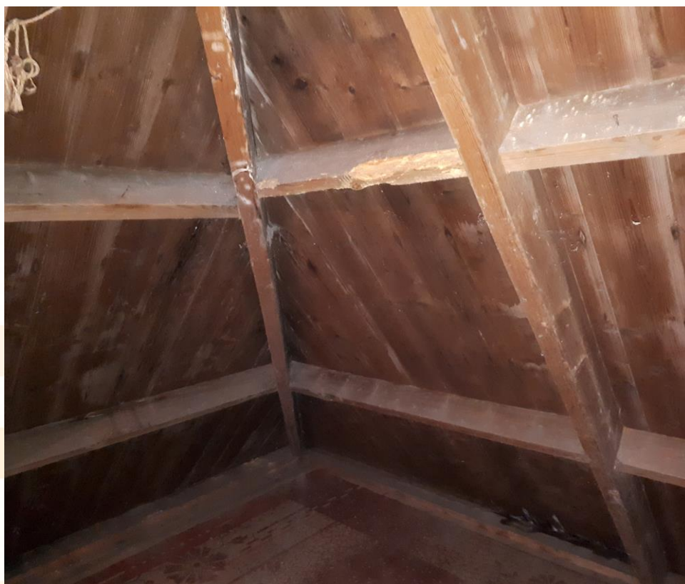
FOTO 5: binnenzijde kap (te lichte) houten spanten
