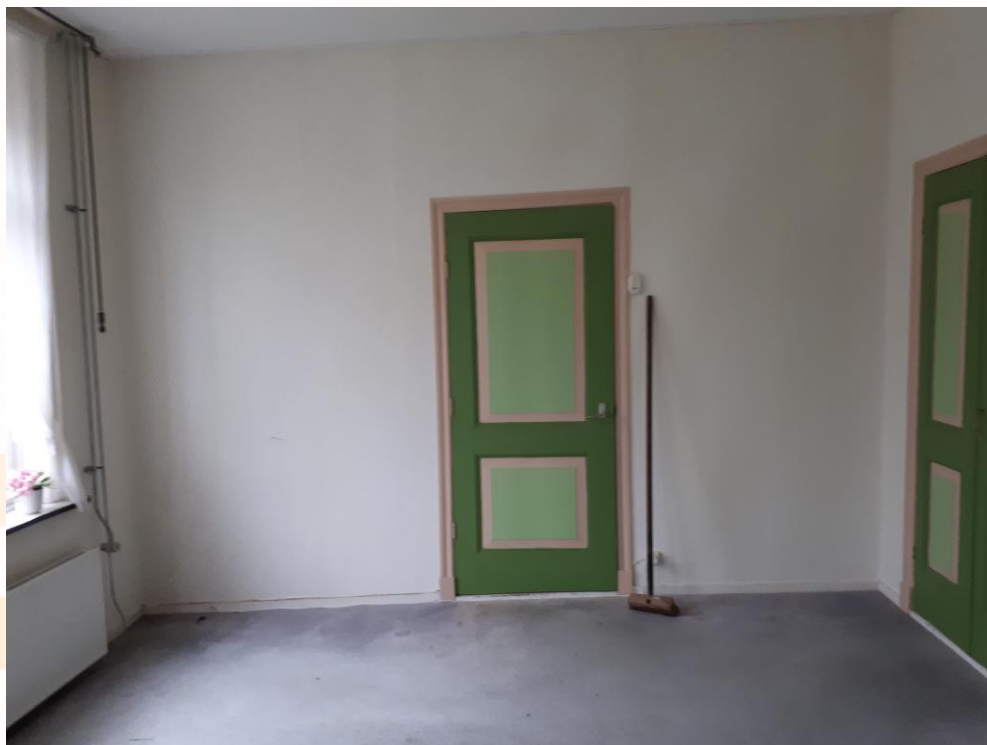
FOTO 1: scheve vloer met deur "scheluw" in kozijn
