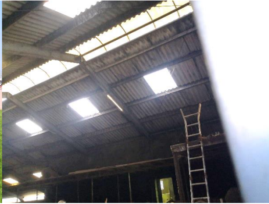
Figuur 2.8 (links): De zijkant van de koeienstal direct langs de weide; Figuur 2.9 (rechts): De binnenkant van de koeienstal. Er is geen dakisolatie aanwezig onder de golfplaten. Er zijn geen nesten waargenomen in de stal.
