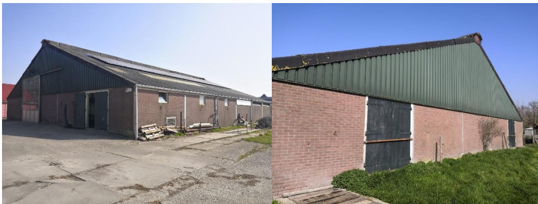
Figuur 2.6 (links): De koeienstal op het plangebied. Het dak bestaat uit golfplaten en heeft geen isolatie. Verder zijn de muren deels gemetseld, en bestaan deels uit damwand; Figuur 2.7 (rechts): De achterzijde van de koeienstal heeft afgesloten deuren.
