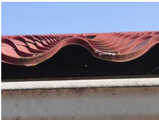
Figuur 2.12 (links): Het dak van de schuur bestaat uit golfplaten met dakpantextuur en is afgesloten voor vogels door middel van een afdichting.
