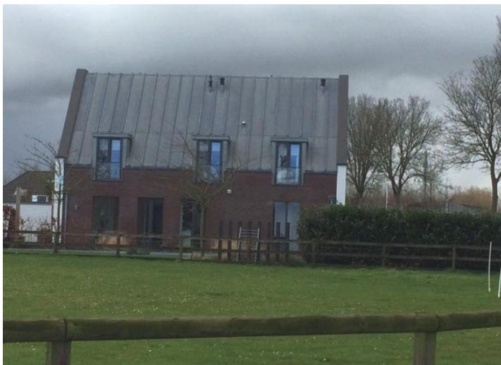
Inpassing met moderne vormgeving en karakteristieke elementen (groter dakvlak dan gevelvlak, verticale vensters). Zicht vanaf de Wijzend.
