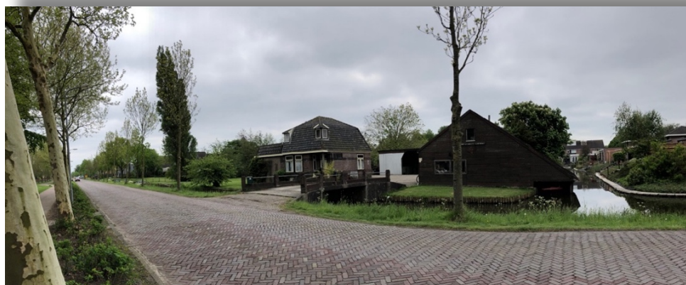
Bestaande situatie Tripkouw 17, Midwoud
