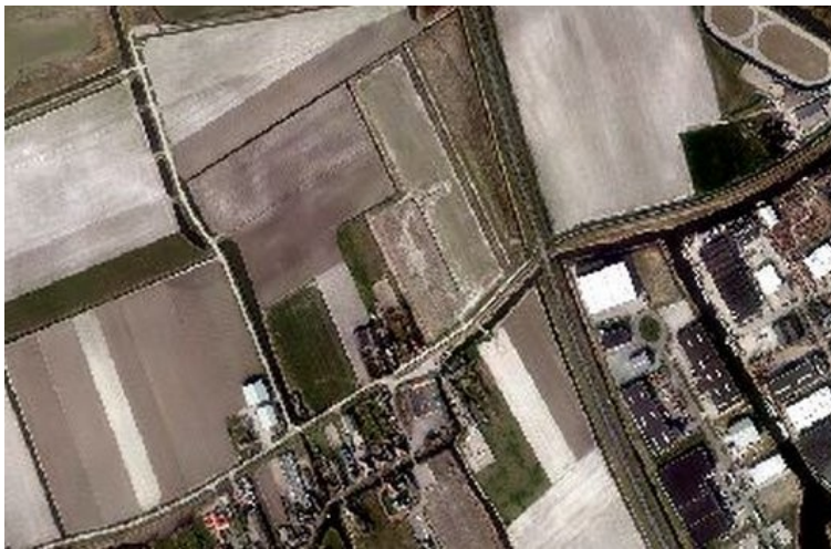
afb.16 Situatie 2016: oorspronkelijke woningen gesloopt
