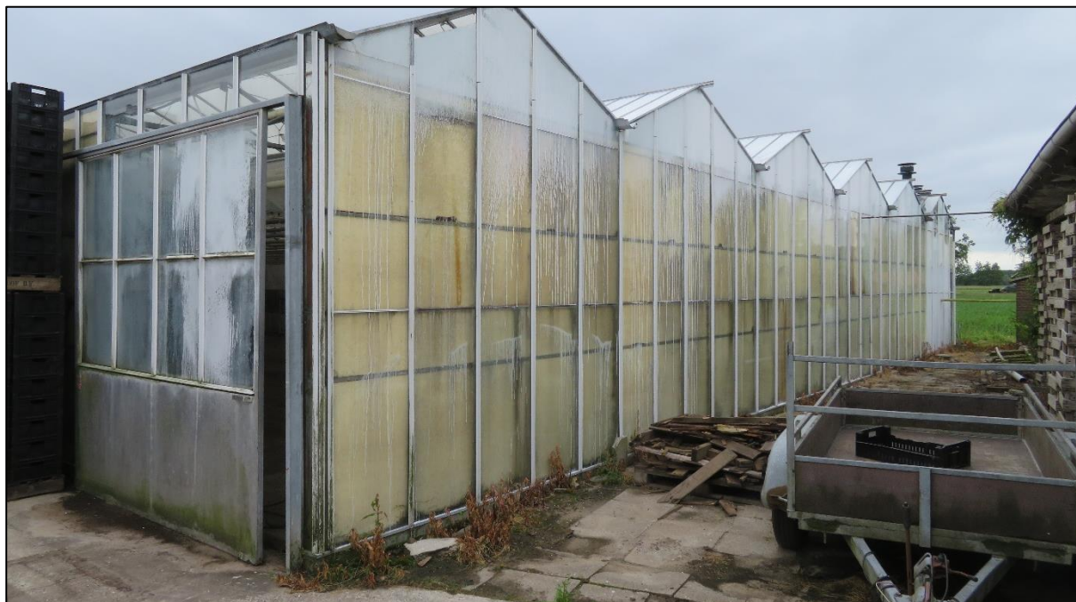
Afb 7: Te slopen kas
