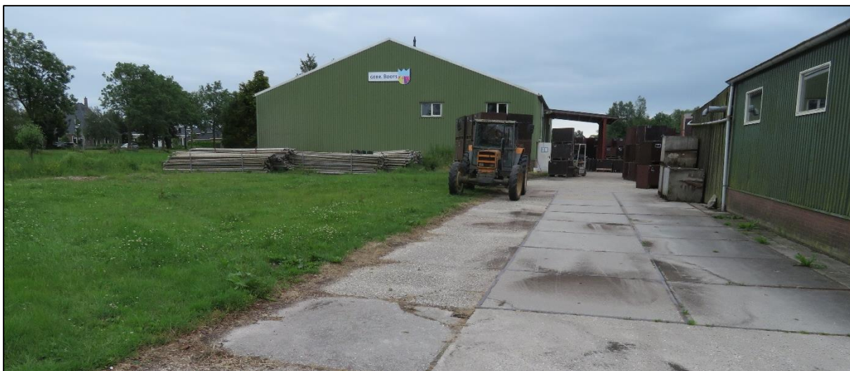
Afb 6: Deel van te slopen bebouwing en verharding
