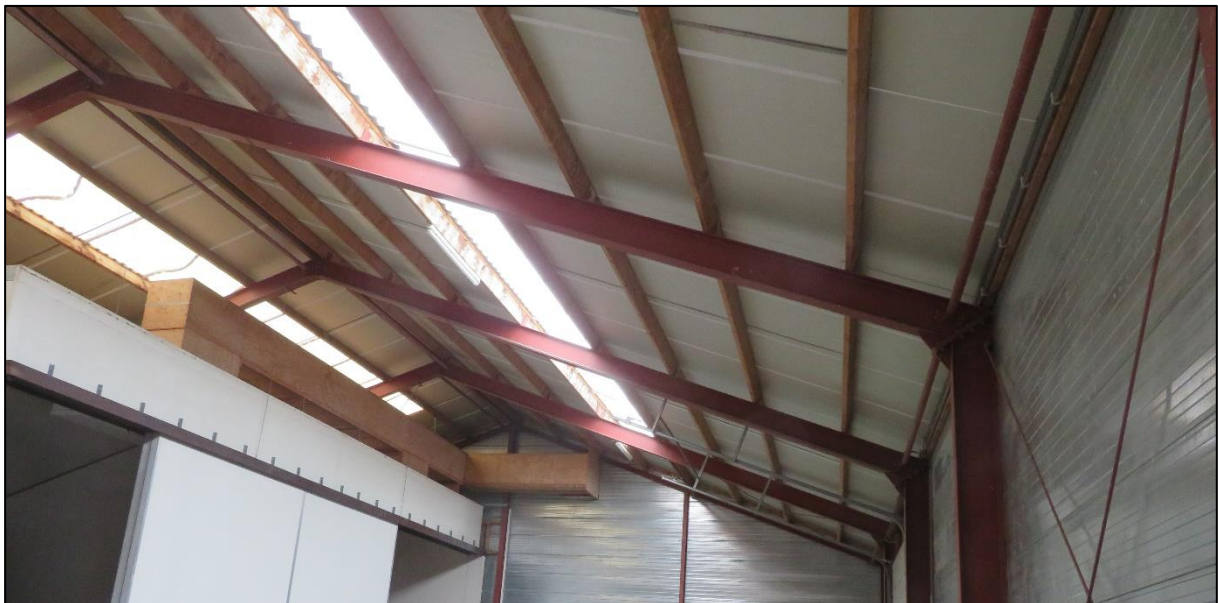
Afb 9: Ook in de grote schuur geen aanwijzingen dat er genesteld wordt
