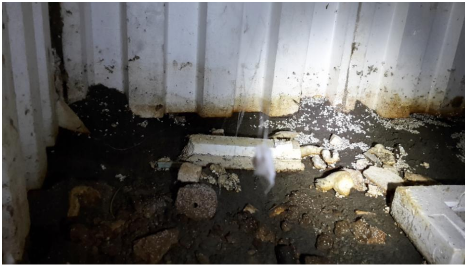
Historische waterlijn zichtbaar in kruipruimte
