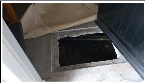
Kruipruimte + Vloerpeil nr.29:
