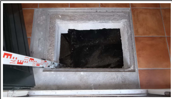
Kruipruimte + Vloerpeil nr.9:
