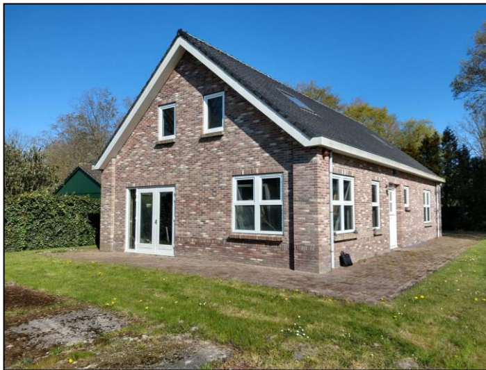
Afbeelding: aanzicht bestaande schuur ter plaatse van het perceel Buurtje 3A.
