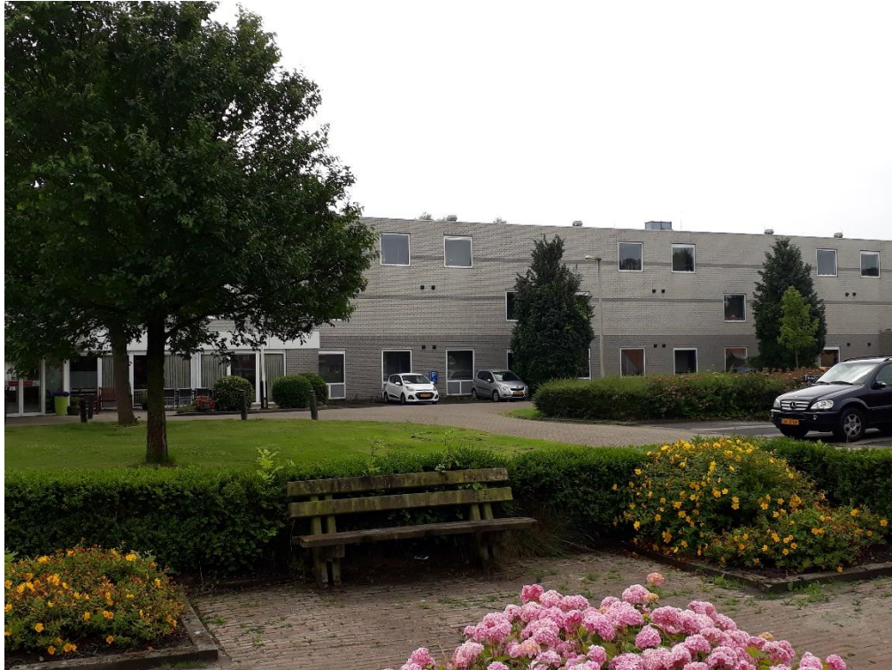
Te slopen gedeelte van verzorgingshuis
