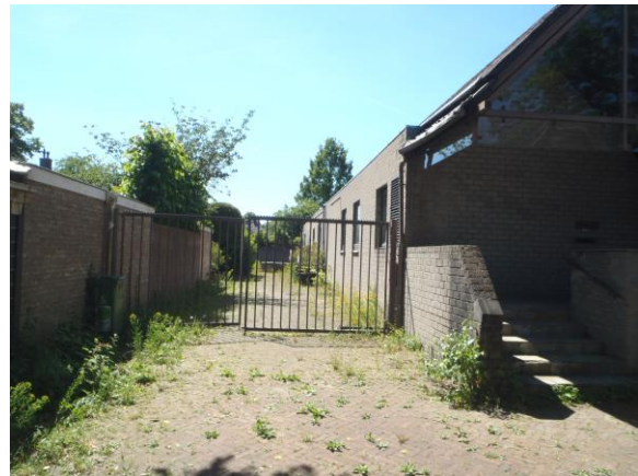
Figuur 8: Overzichtsfoto bebouwing
