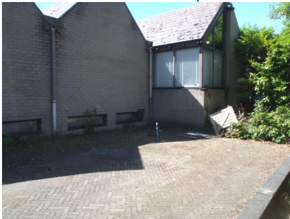
Figuur 7: Overzichtsfoto bebouwing
