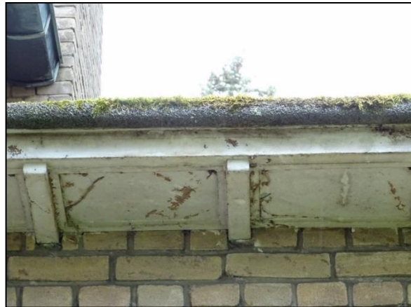
Figuur 16. De bitumen dakbedekking is strak afgewerkt en heeft geen openingen / kieren.
