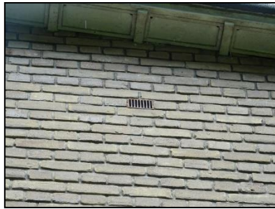
Figuur 22. Gevelventilatie is afgewerkt met ventilatieroosters.
