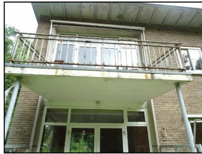
Figuur 10. Zuidelijk aanzicht van de woning met een balkon.
