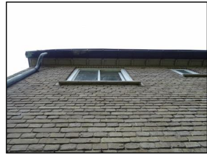
Figuur 11. Dakrand van de woning.
