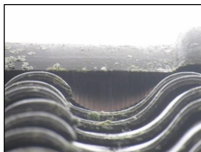
Figuur 11. Aanwezig ondervorstband onder de nokpannen.
