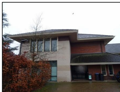
Figuur 4. Noordzijde van de onderzoekslocatie.
