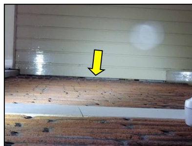
Figuur 14. Opening tussen de muur en het boeideel.
