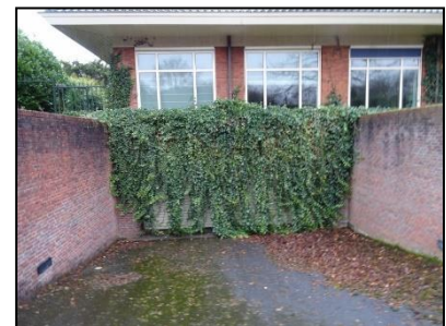
Figuur 5. Westzijde van de onderzoekslocatie. De ingang van de parkeergarage is overgroeid door klimop.
