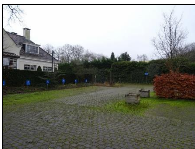
Figuur 6. Het parkeerterrein is deels overgroeid door gras en mos.
