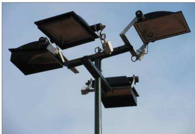
Figuur 5-2: Vleermuisvriendelijke verlichting, gedempt oranje licht, aangepaste armaturen zonder lichtverstrooiing en toepassen op korte palen.
