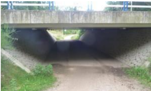
Foto 3 Doorzicht in (fiets)tunnel met half verharding
