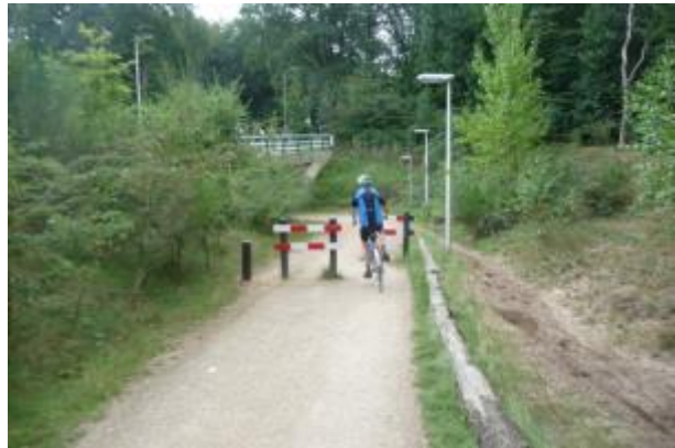
Foto 2 Hekjes halverwege de hellingbaan naar de (fiets)tunnel met daarnaast een ruiterpad
