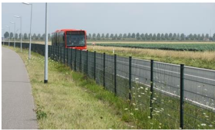
Figuur 6-6 Voorbeeld hekwerk
