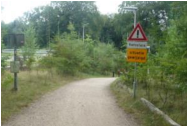
Foto 1 Doorzicht in (fiets)tunnel met halfverharding
