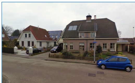
8 Aangrenzende woningen zuidzijde
