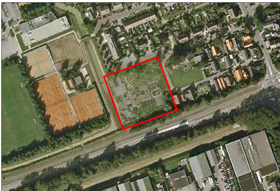
Figuur 1. Bestaande situatie in het plangebied
