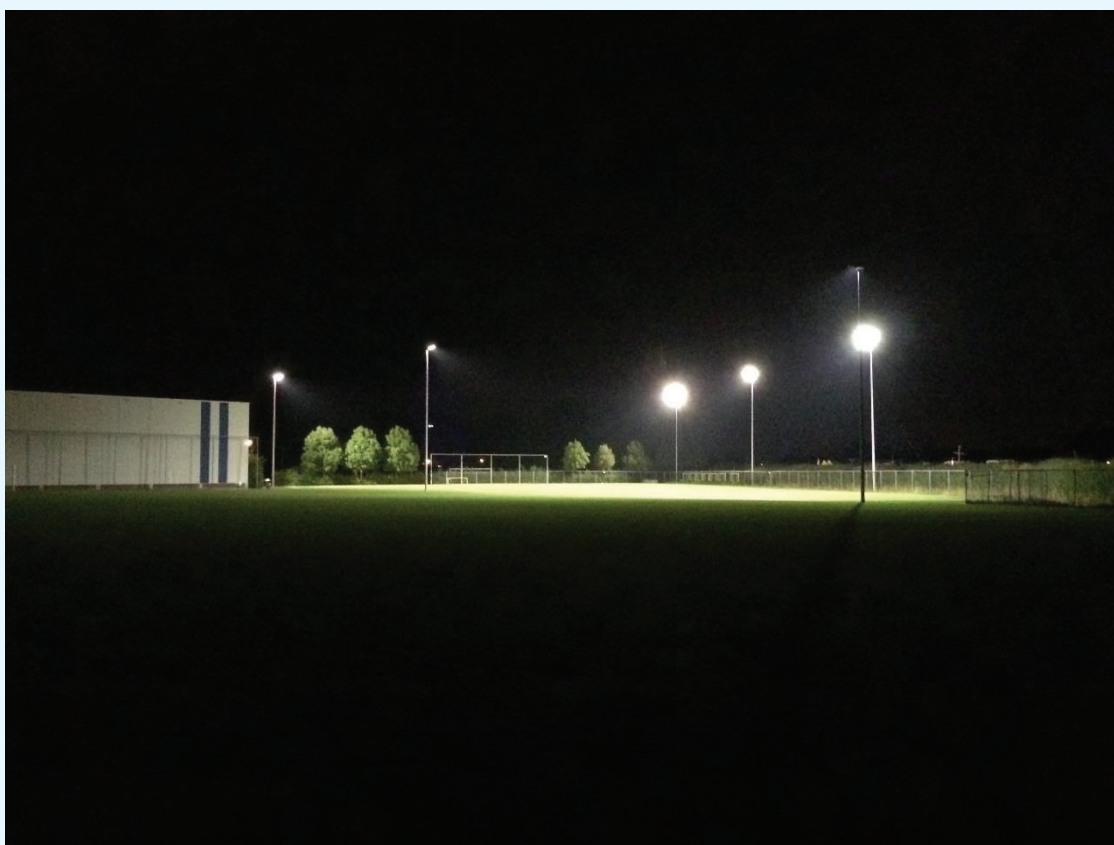
figuur 5: zicht op de lichtmasten vanaf positie 4.
