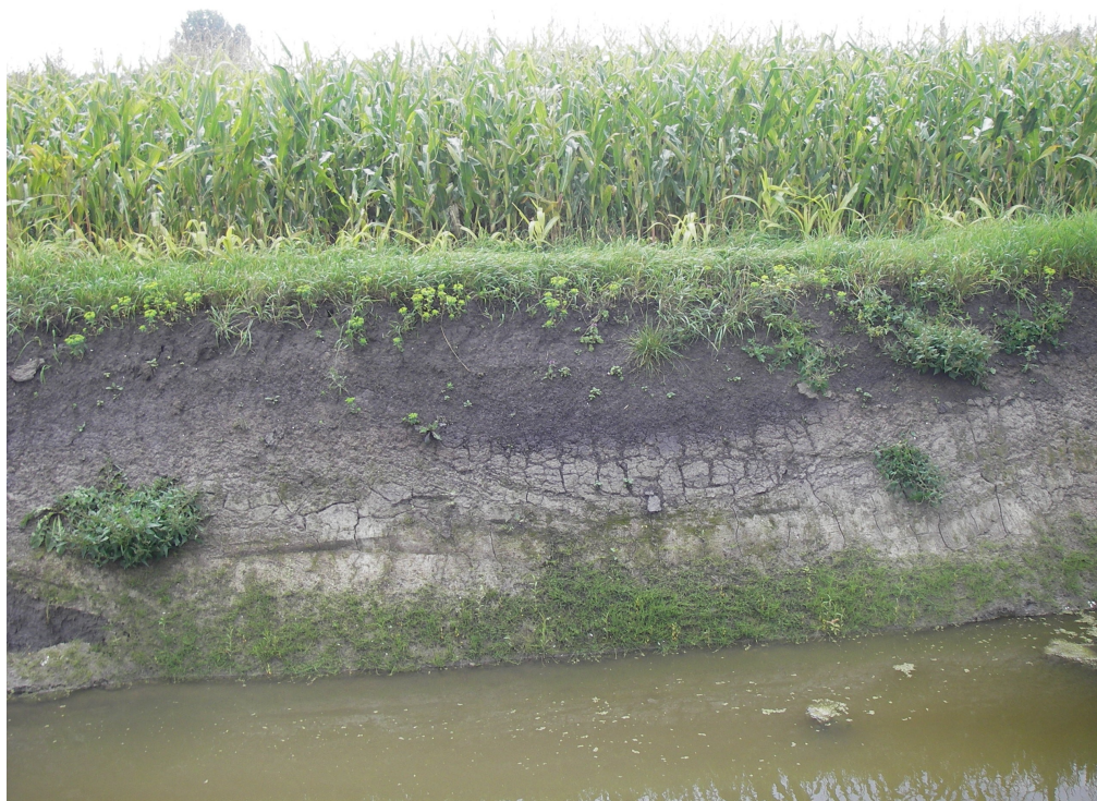
Figuur 6. Sint Pancras, Vronermeerweg. Het zuidprofiel van de langs de zuidrand van het plangebied gelegen sloot. De polygoonvormige uitdrogingsstructuren op het midden van het afgebeelde deel van het profiel geven de ligging van een met klei dichtgeslibd geultje weer.
