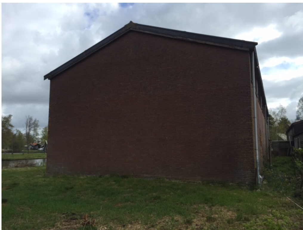
Figuur 2 De schuur op het noordwestelijk deel van de planlocatie is in gebruik geweest als machinewerkplaats en wordt omgevormd naar praktijkruimte.
