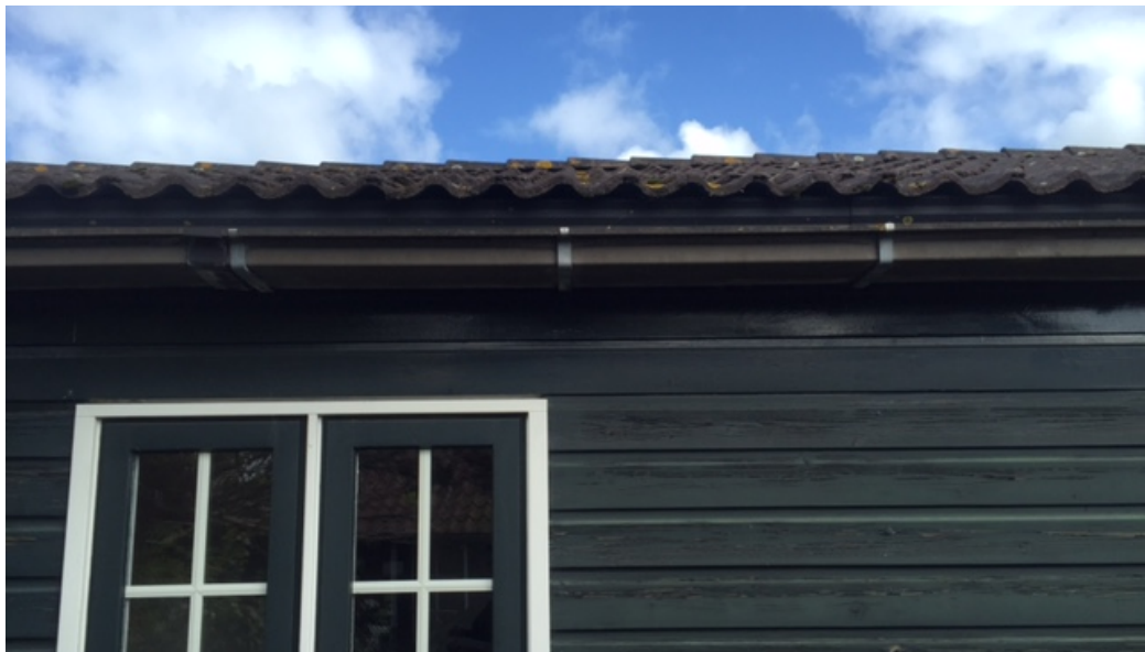
Figuur 1 Onder de eerste rij dakpannen is vogelschroot aangebracht waardoor het voor vogels en vleermuizen onmogelijk is om de ruimte te gebruiken als nest- en/of verblijfslocatie.
