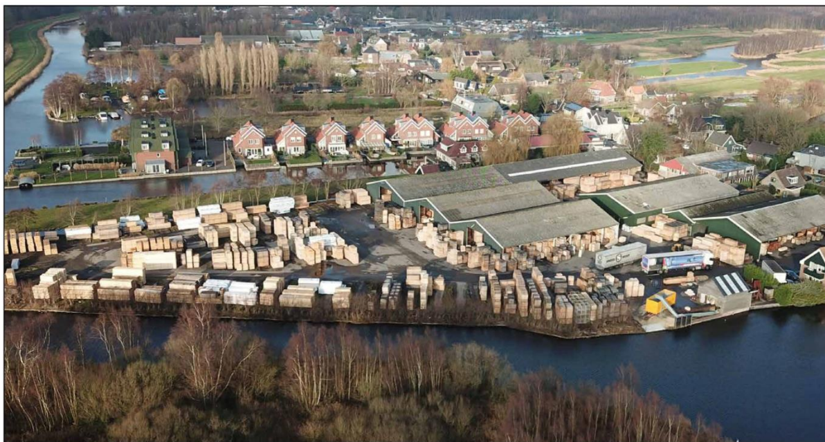
Afbeelding 2.2 Huidige situatie plangebied (Bron: ErfGoed landelijk bouwen)
